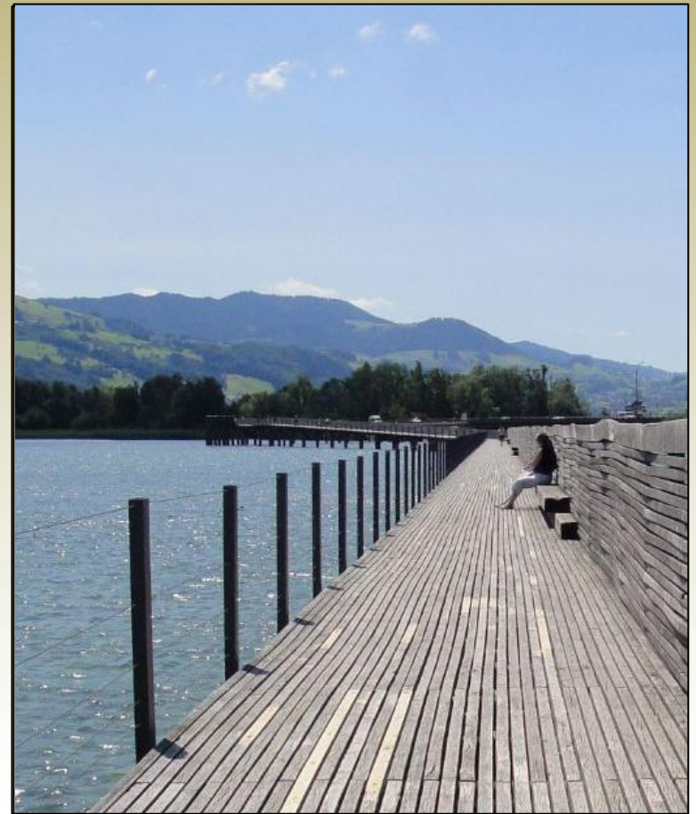
Passerelle pour pédestre à Rapperswil (SG)
