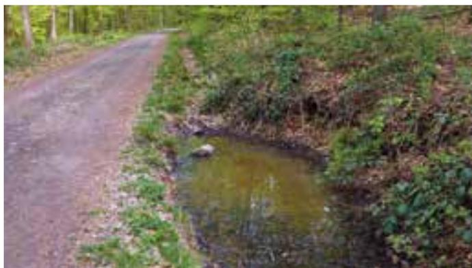
Ableitung von Grabenwasser durch Mulde zur Versickerung im Unterhang
