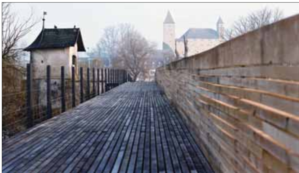
Fig. 39: Le 6 avril 2001, une nouvelle passerelle en bois sur le lac de Zurich été ouverte au public entre Rapperswil (SG) et Hurden (SZ). Grâce à une collaboration et à une planification précoces entre le maître d'œuvre, les ingénieurs et les architectes d'une part et les acteurs de l'économie de la forêt et du bois d'autre part, 70% du bois de chêne utilisé pour cet important projet sont issus des forêts suisses [63] , exemple d'un flux d'informations efficace dans la filière du bois. (Photo Katharina Wernli)
