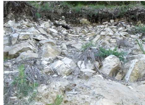
Fig. 21 Couverture locale des sols par des éboulis superficiels
